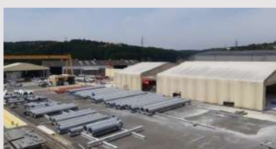
広い屋外塗装スペース
