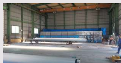
屋内塗装ブース
