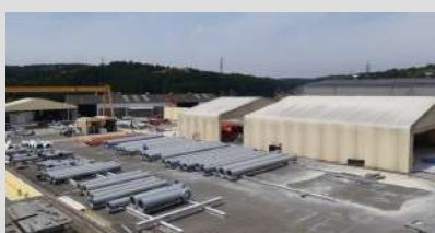
広い屋外塗装スペース
