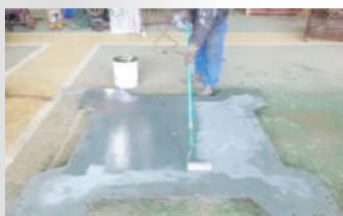
剥離剤ローラー塗布
