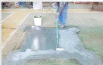
剥離剤ローラー塗布
